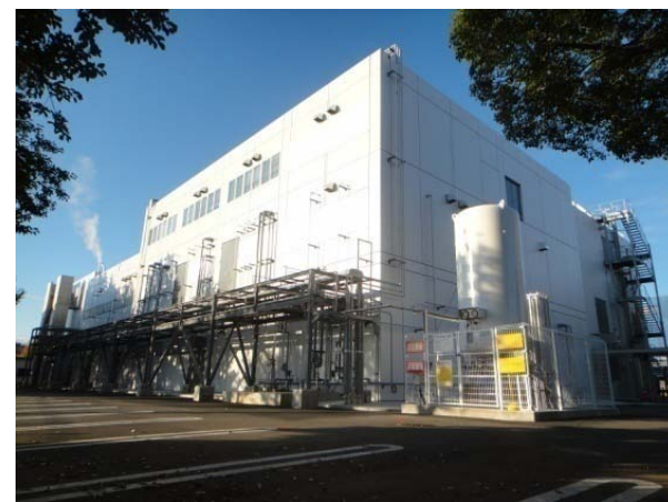
つくばバイオ研究センター 開発用原薬製造設備
