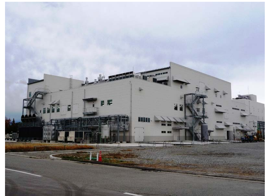
醗酵技術研究棟
