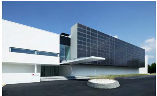
つくば研究センターの太陽光発電パネル
